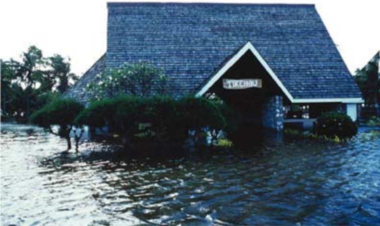
Les infrastructures de Polynésie française doivent tenir compte des nouvelles contraintes entraînées par le changement climatique
