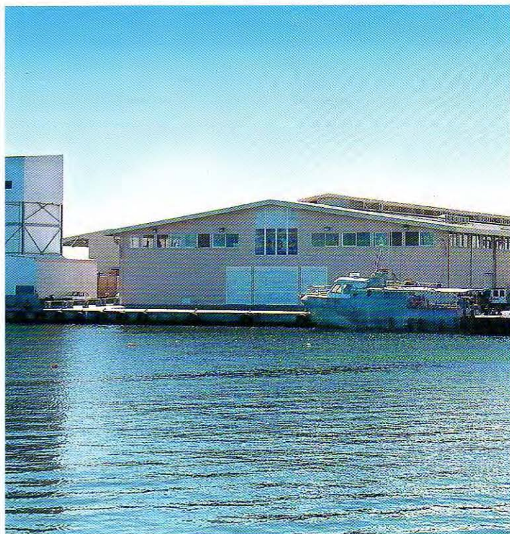
Le bâtiment de mareyage export frais est opérationnel depuis le 1 er juillet 2003
