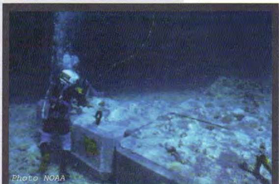
Photo NOAA Restauration physique à l'aide de plaques de béton (site Alec Owen Maitland)
