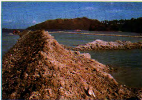
Dragage et remblaiement
