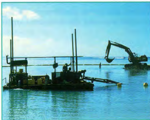
1 - Reprofilage et curage des fonds
