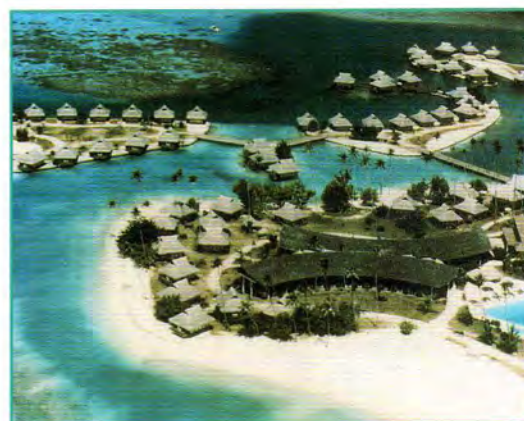
3 - Vue d'un chantier après restauration physique du fond et du littoral
