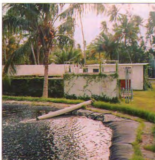
Le club Méditerranée à Moorea : un bon exemple d'assainissement collectif où les eaux traitées servent à l'arrosage.
