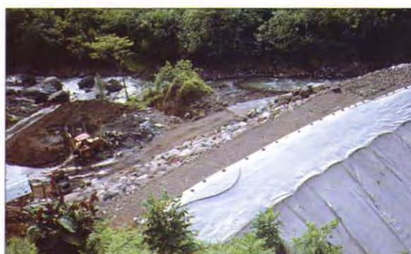
Terrassements pour la construction d'ouvrages (centrales hydroélectriques, châteaux d'eau) : bien que ponctuel, le danger est représenté par les volumes de terre très importants qui sont déblayés.
